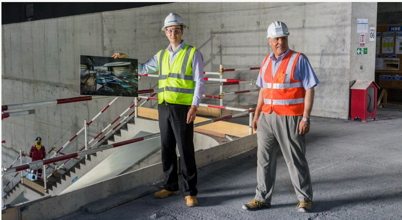
Na kontrolním dni stavby. Foto: archiv Kamila Dunaje
